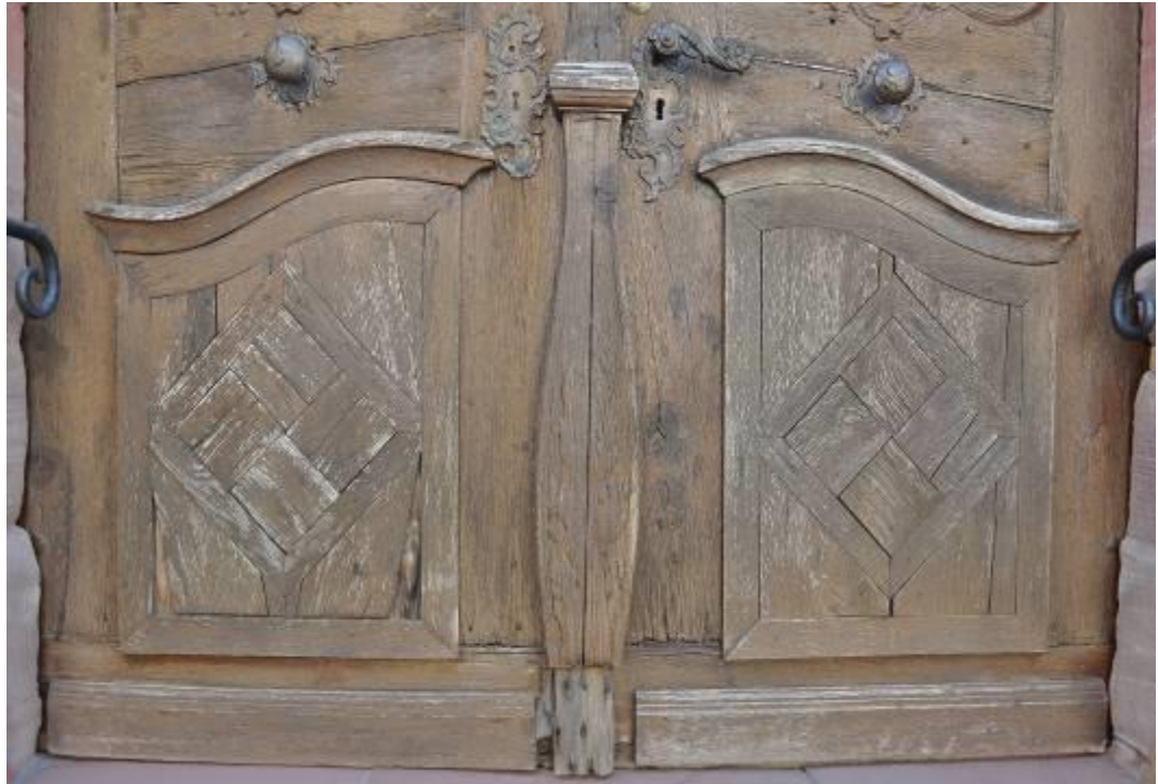
Untere Füllungen, fehlende Basis der Schlagleiste
