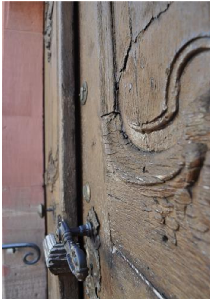
Stark abgewitterte spröde und trockene Holzpartien
