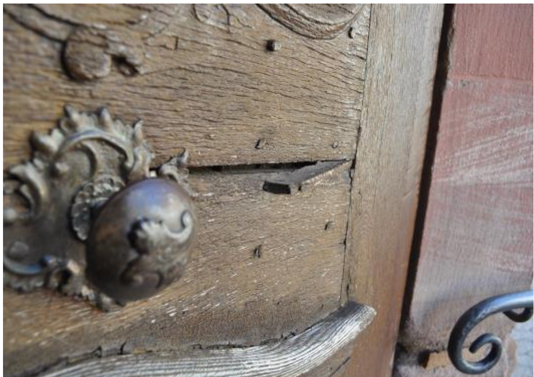
Offene Fuge, gelöster Span
