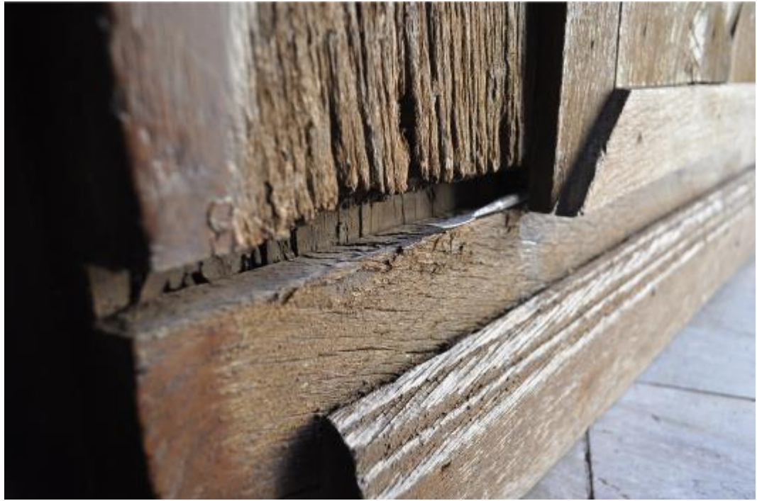
Sichbare vertikale Verbretterung, breite Fugen unter den unteren Füllungen
